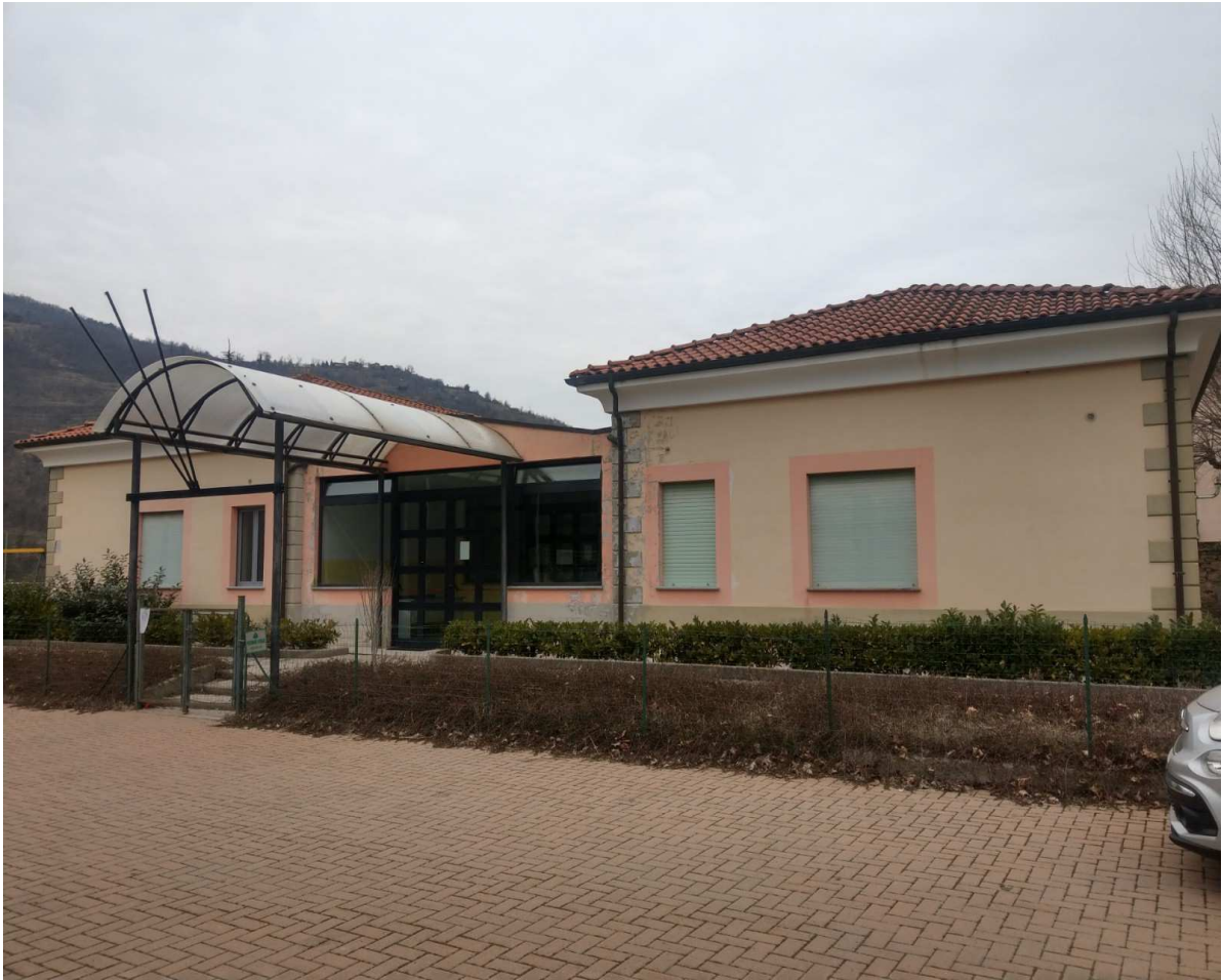
La struttura scolastica oggetto d'intervento a Monesiglio
