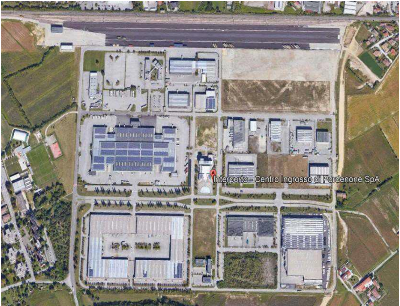
Fonte Interporto - Centro Ingresso di Pordenone (ICIP)
